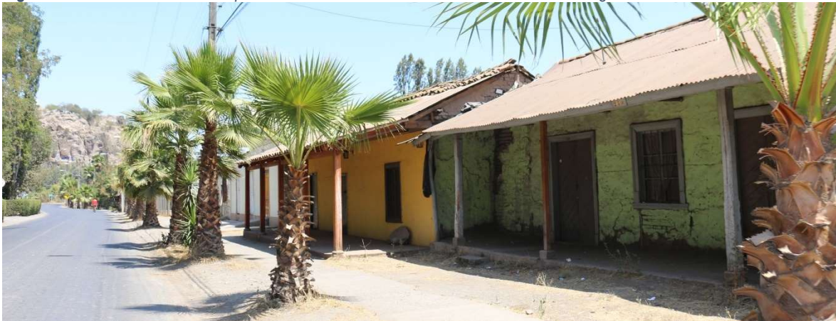
Figura 4: Edificaciones actuales que conservan la línea de construcción de fines del siglo XIX.
